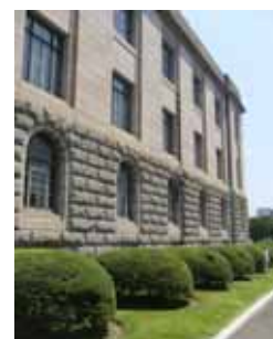
1階外壁は黒髪石コブ出し 2階からは尾立石：切削材
